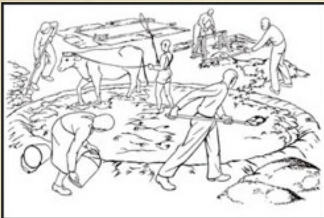
si tratta di un sistema costruttivo per erigere murature portanti che prevede l'esecuzione di un impasto di terra paglia denso che viene preparato e poi direttamente trasportato e impilato o gettato per costruire una muratura spessa, modellata senza casseformi. La superficie viene poi parificata e raddrizzata tagliando eventuali parti in eccesso.
